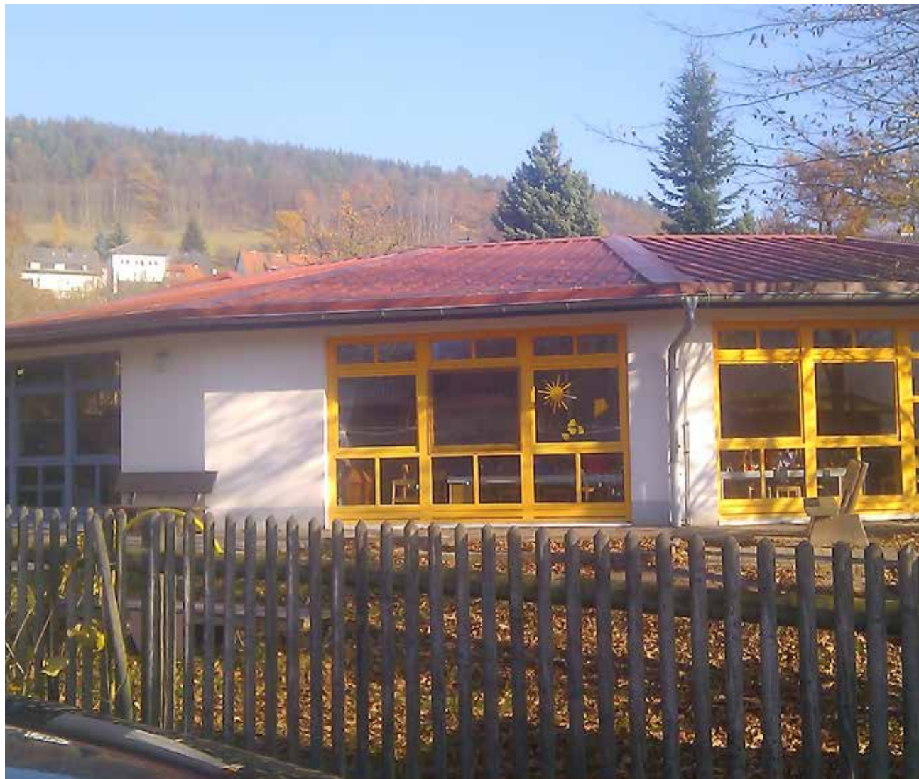
Der Philippsthaler Kindergarten wird um 20 neue Kinderkrippenplätze erweitert. Damit ist die Marktgemeinde gut für die Zukunft aufgestellt und kann die im August 2013 in Kraft tretenden gesetzlichen Vorgaben umsetzen.
