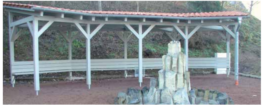
Nach Fertigstellung der Brunnenanlage in Röhrigshof wird für das Dorfgemeinschaftshaus und das Feuerwehrgerätehaus mit Bürgerbeteiligung ein Sanierungskonzept erarbeitet.
